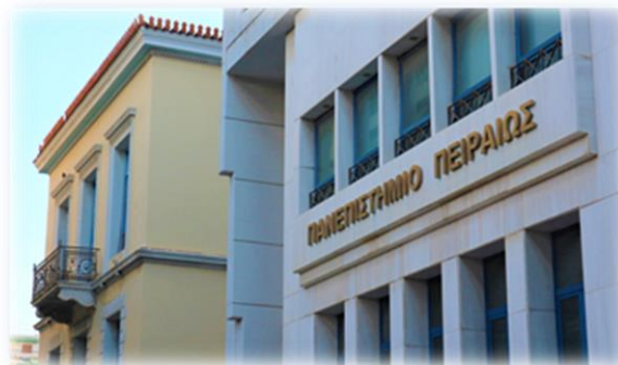
Πανεπιστήμιο Πειραιώς - Κτίριο Βιομηχανικής Διοίκησης & Τεχνολογίας
