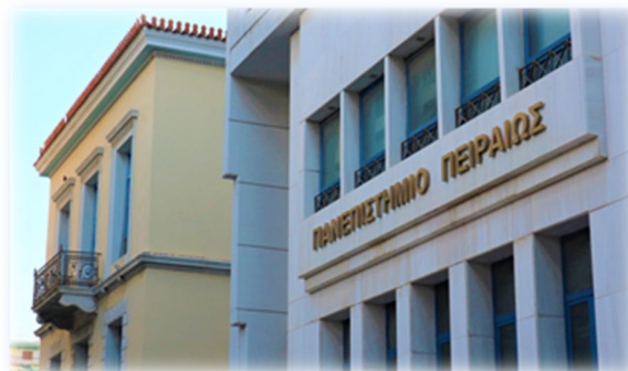
Πανεπιστήμιο Πειραιώς - Κτίριο Βιομηχανικής Διοίκησης & Τεχνολογίας
