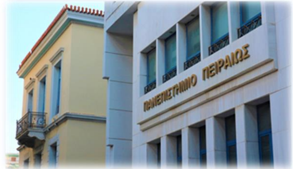
Πανεπιστήμιο Πειραιώς - Κτίριο Βιομηχανικής Διοίκησης & Τεχνολογίας
